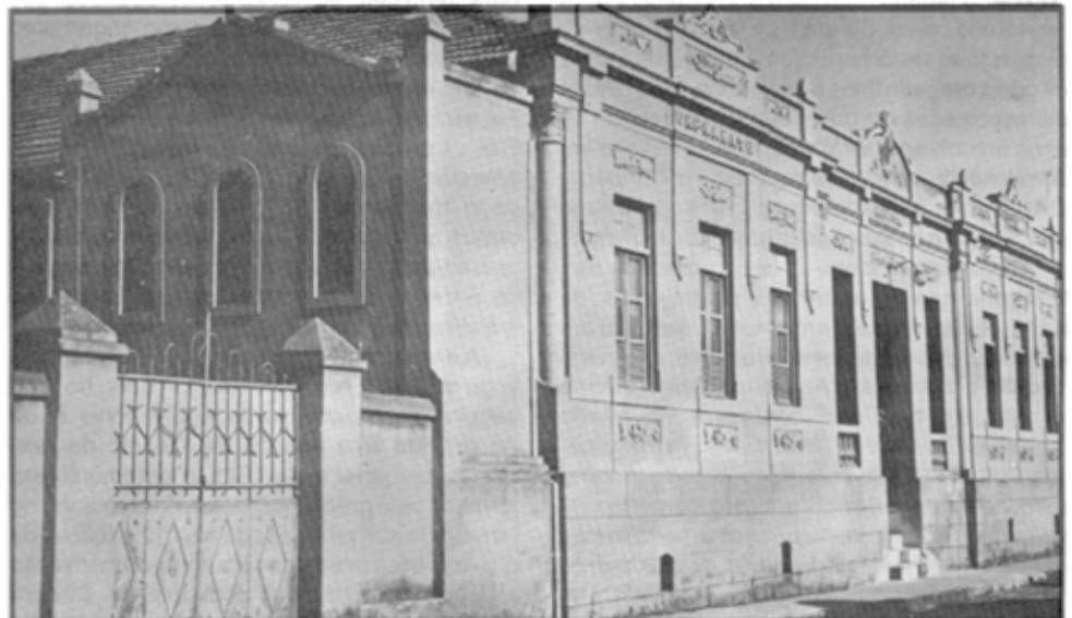
Prédio onde funcionou originalmente o Orfanato Santa Terezinha (Rua Capitão Izidro). Doação de Inês Santos
